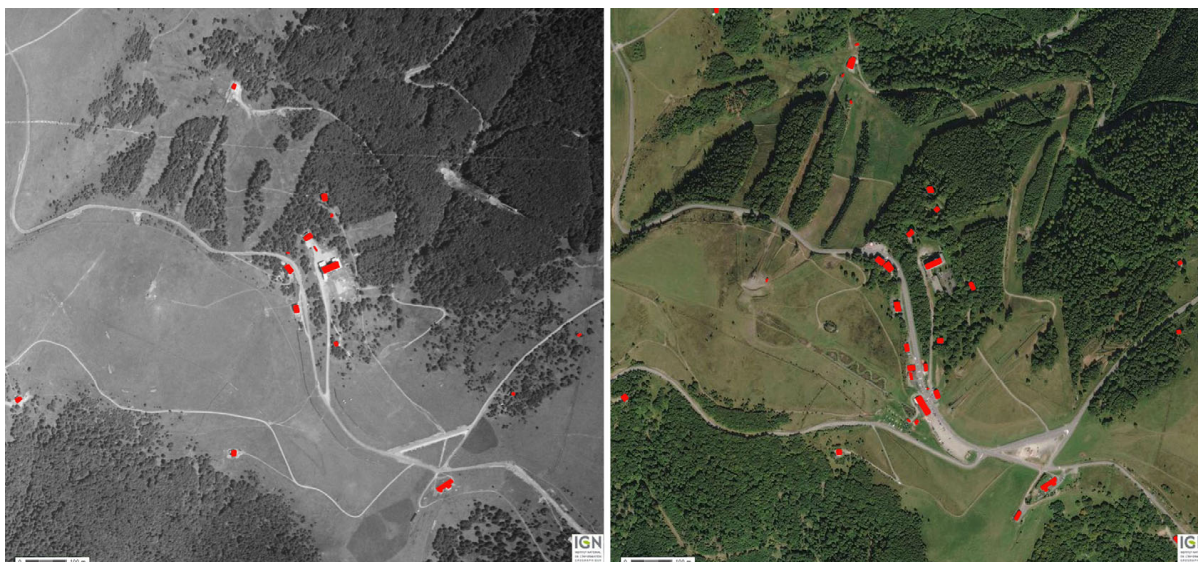
L'aménagement du domaine skiable implique la mise en place d'équipements lourds : routes d'accès, larges parkings, pistes de ski, de luge, téléskis, bâtiments de service, hébergement. Le site naturel devient un site touristique aménagé. Le Markstein photographies aériennes de 1956 et 2012
