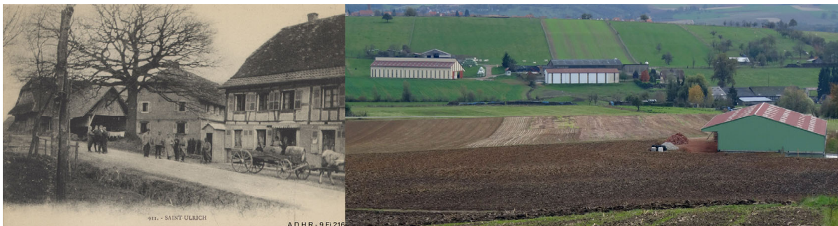
Quittant progressivement les villages, les bâtiments agricoles s'affirment dans le paysage, formant parfois une couronne autour des villages St-Ulrich (carte postale début XXème siècle, source archive départementale du Haut-Rhin) et Uhrwiller
