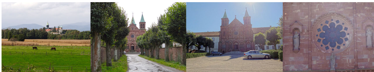
Un ensemble bâti monumental dominant la vallée
