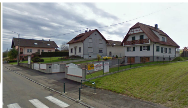
A Muespach, les habitations construites avant 1960 conservent une implantation à proximité l'espace public et s'orientent pignon sur rue. De nouvelles constructions plus récentes s'éloignent de la rue, impactant l'ambiance rue constitutive de ces villages. (fond street view)
