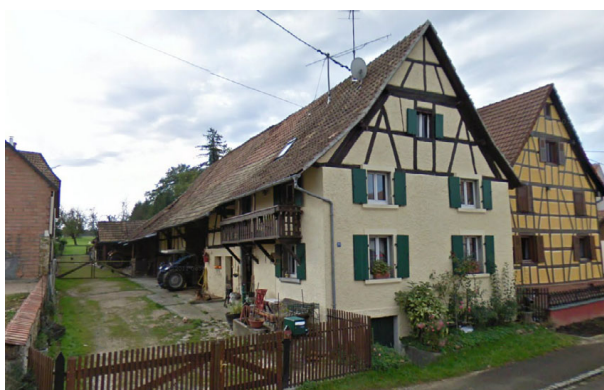
MUESPACH, maison-bloc (fond street view)
