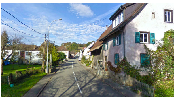
Lingsdorf, une structure de type village-rue
