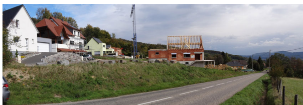
Le lotissement en entrée de village depuis la rue de Ferrette. Une situation hors du village, sur d'anciens vergers. La pente nécessite d'importants enrochements qui n'assurent pas une bonne intégration des habitations dans le paysage. Sondersdorf
