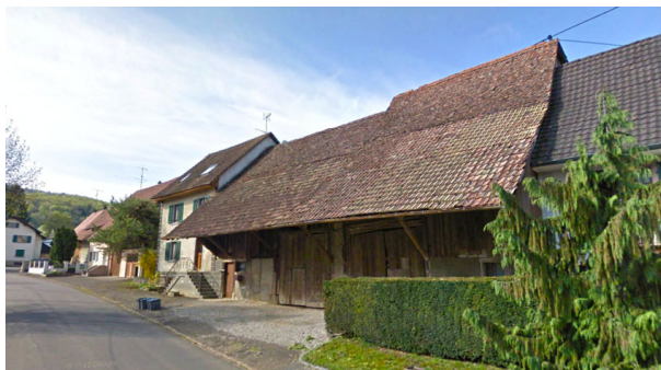
La ferme-bloc le long de la rue. Wolschwiller
